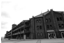
Deuxième vue (plus lumineuse)
