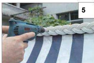
5 Opzionalmente, è possibile collegare la modanatura alla cesta superiore. A tale scopo, unire le parti della modanatura (10) e avvitare utilizzando le viti fornite sulla cesta superiore (sopra la tenda da sole).
