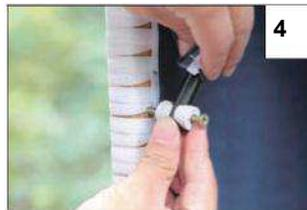
4 Per fissare la tenda da sole, utilizzare la vite (A) comprese le fascette di plastica (D). Inserire ogni fascetta intorno alla guida della tenda da sole e avvitare la vite nel punto segnato dall'interno nel pannello laterale.
