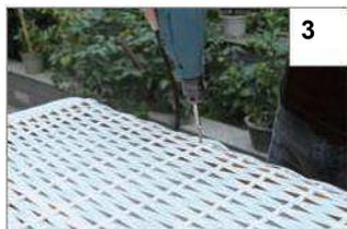
3 Con l'ausilio di 2 viti (A) il pannello del tetto è fissato anche alla parete posteriore. I punti corrispondenti sono contrassegnati da frecce.
