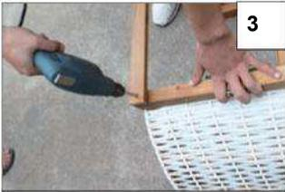
3 Quindi avvitare la parte anteriore e la cassa inferiore con le lamelle piatte (3) – utilizzare 2 viti per parte (C).
