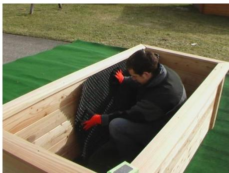
Anschließend verkleiden Sie das Hochbeet innen mit der beiliegenden Noppenfolie (Noppen zur Wand!). Nageln Sie die Folie mehrere Male mit den Breitkopfnägeln an. Wenn die Folie aus mehreren Teilen besteht überlappen Sie diese ca. 5 cm. Falls die Folie einen glatten Streifen hat, verwenden Sie bitte diesen unten bei dem Fundamentrahmen.
