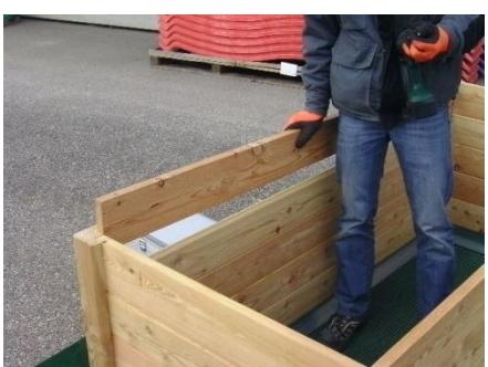
Pour vous aider, vous pouvez assembler les planches avec précaution à l'aide d'une sangle d'arrimage de manière à ce que les planches murales s'appuient sur le montant de l'angle.
