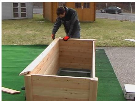
Ziehen Sie nun die Schrauben des Fundamentrahmens fest an.
