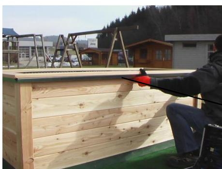
Wenn Sie sich für die optionale Schneckenkante entschieden haben, dann schrauben Sie diese mit den Schrauben 4,2x16mm unten am Handlauf fest.
