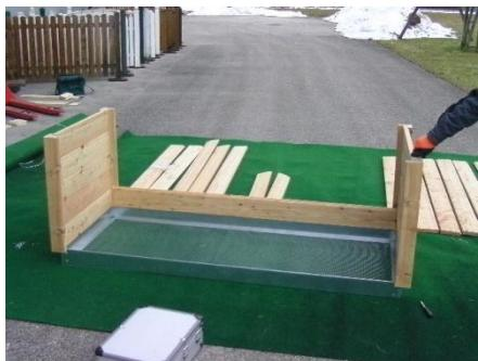
Placez les pièces latérales côté court sur le cadre de fondation (placez la rainure de la planche sur la languette du cadre de fondation !) et vissez les planches murales plus longues sur les colonnes d'angle.
