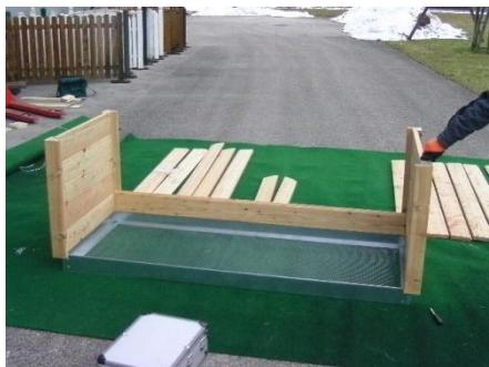
Stecken Sie die fertigen kurzen Seitenteile auf den Fundamentrahmen (Nut des Brettes auf Feder des Fundamentrahmens stecken!) und verschrauben Sie die längeren Wandbretter mit den Ecksäulen.
