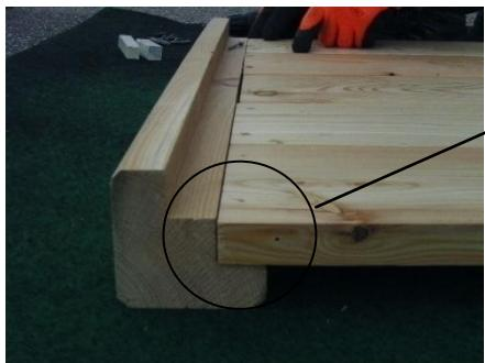
La planche sans languette est montée en haut et doit dépasser d'environ 1 cm. Veuillez vous assurer que les planches murales sont directement en contact avec les montants d'angle.
